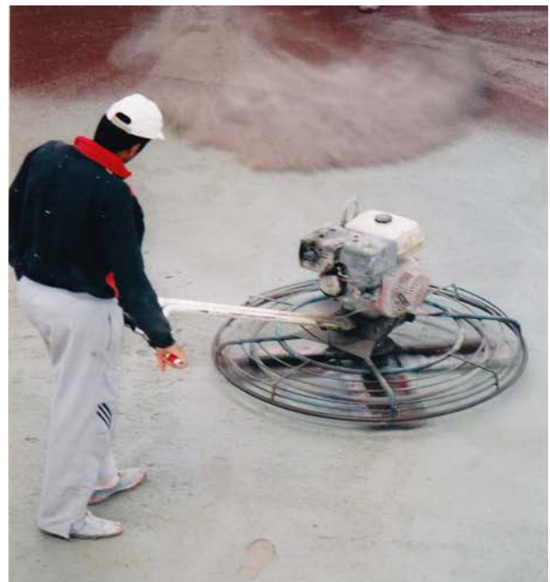
Detalle del espolvoreo del premezclado de capa de rodadura
