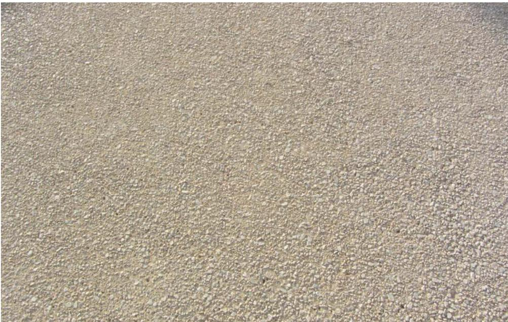
Superficie de hormigón tratada con desactivante de fraguado.
