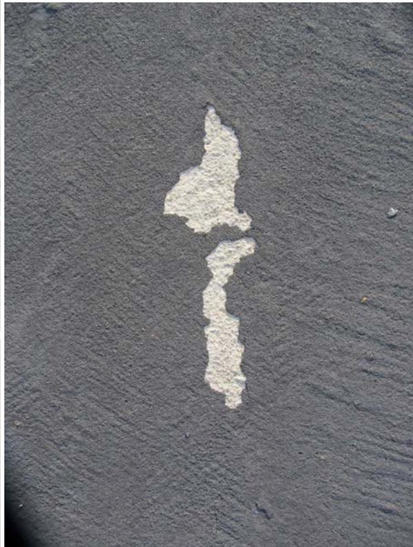
Izquierda, carril bici y viales acabados con slurry sobre hormigón. Derecha, algunos defectos de desconches por falta de adherencia al soporte de hormigón pese a haber transcurrido poco tiempo desde la ejecución del pavimento.
