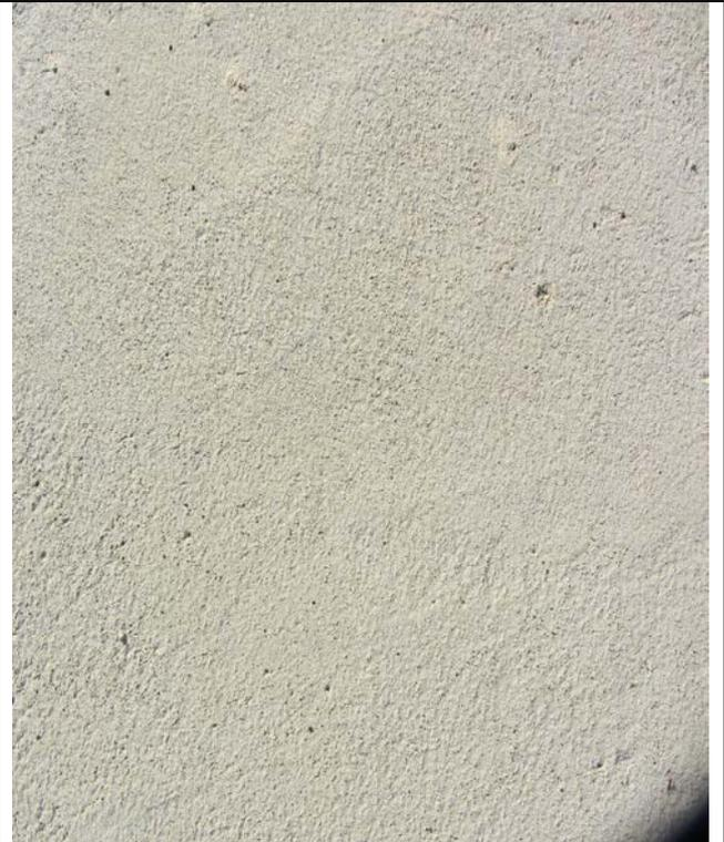
Acerados de hormigón en masa coloreado en tono crema. Acabado con niveladora vibrante. El tono crema se ha obtenido usando cemento gris claro y pigmento amarillo.
